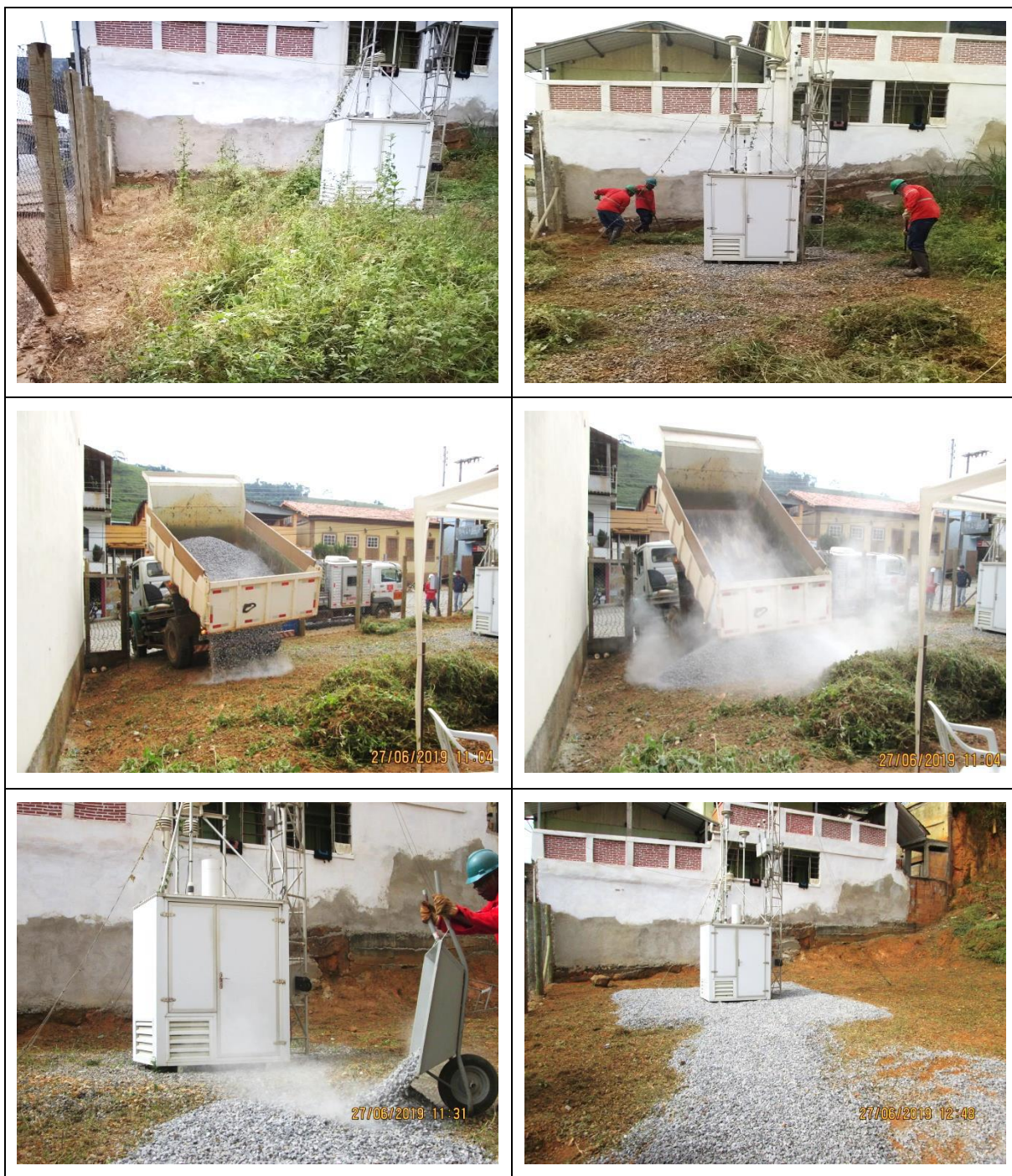
Figura A.15 - Registros fotográficos das atividades de capina manual, remoção da vegetação e colocação de brita no acesso à estação Barra Longa Centro – 27/06/2019
